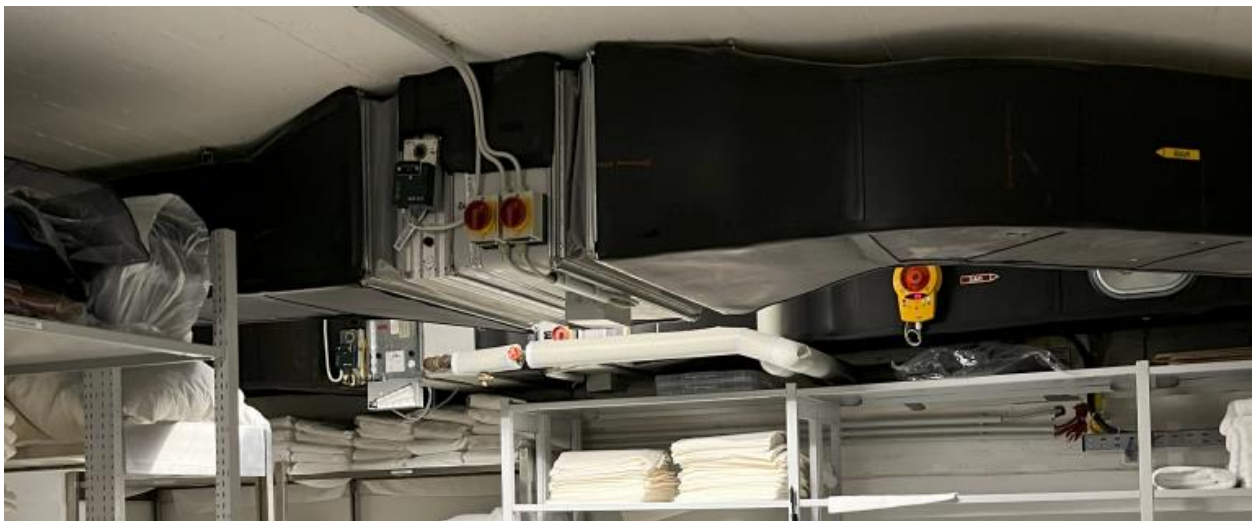
Abbildung 11 Lüftungsgeräte der Bar
